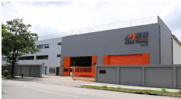
震雄集团香港总部
